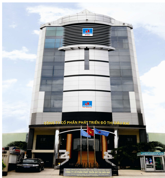
Trụ sở làm việc của Công ty PVC-Mekong
